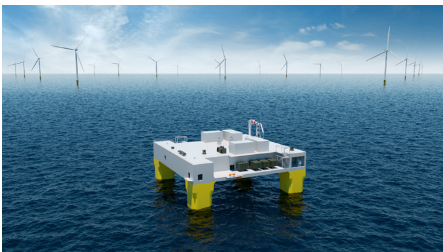
Figur 4: Flytende HVAC-stasjon, Aibel generelt konsept for 500 – 1500 MW til venstre. Første realisererte flytende substasjon i Fukushima testpark for flytende vind i Japan til høyre.
