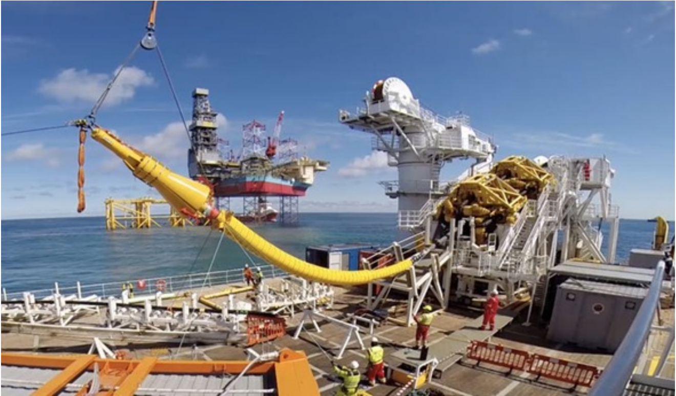
Figur 33: Inntrekkshode og bøystiver som under installasjon i forbindelse med elektrifisering ( www.NKT.com ).
